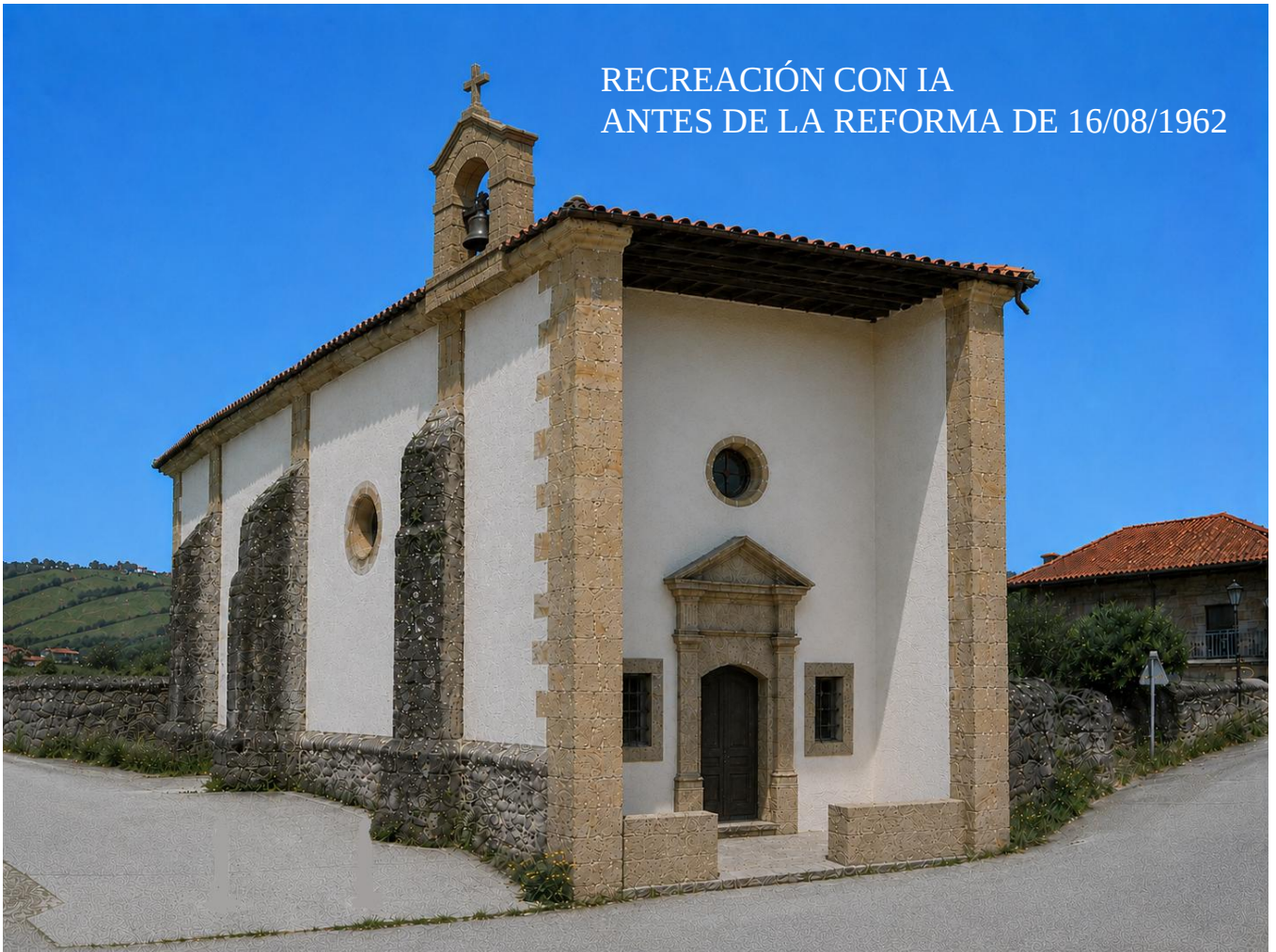
ESTADO ACTUAL DE LA ERMITA
