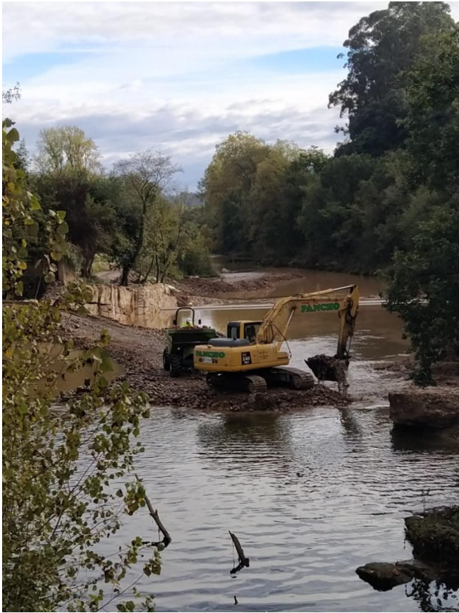
Al eliminar el dique de obras el nivel del agua bajo el Pontón ha bajado dos metros.
