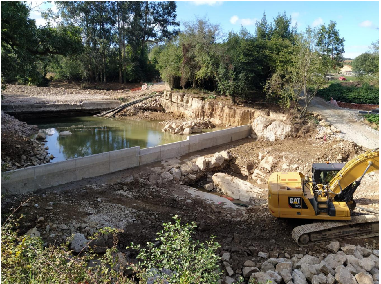
La presa tras quitar el encofrado
