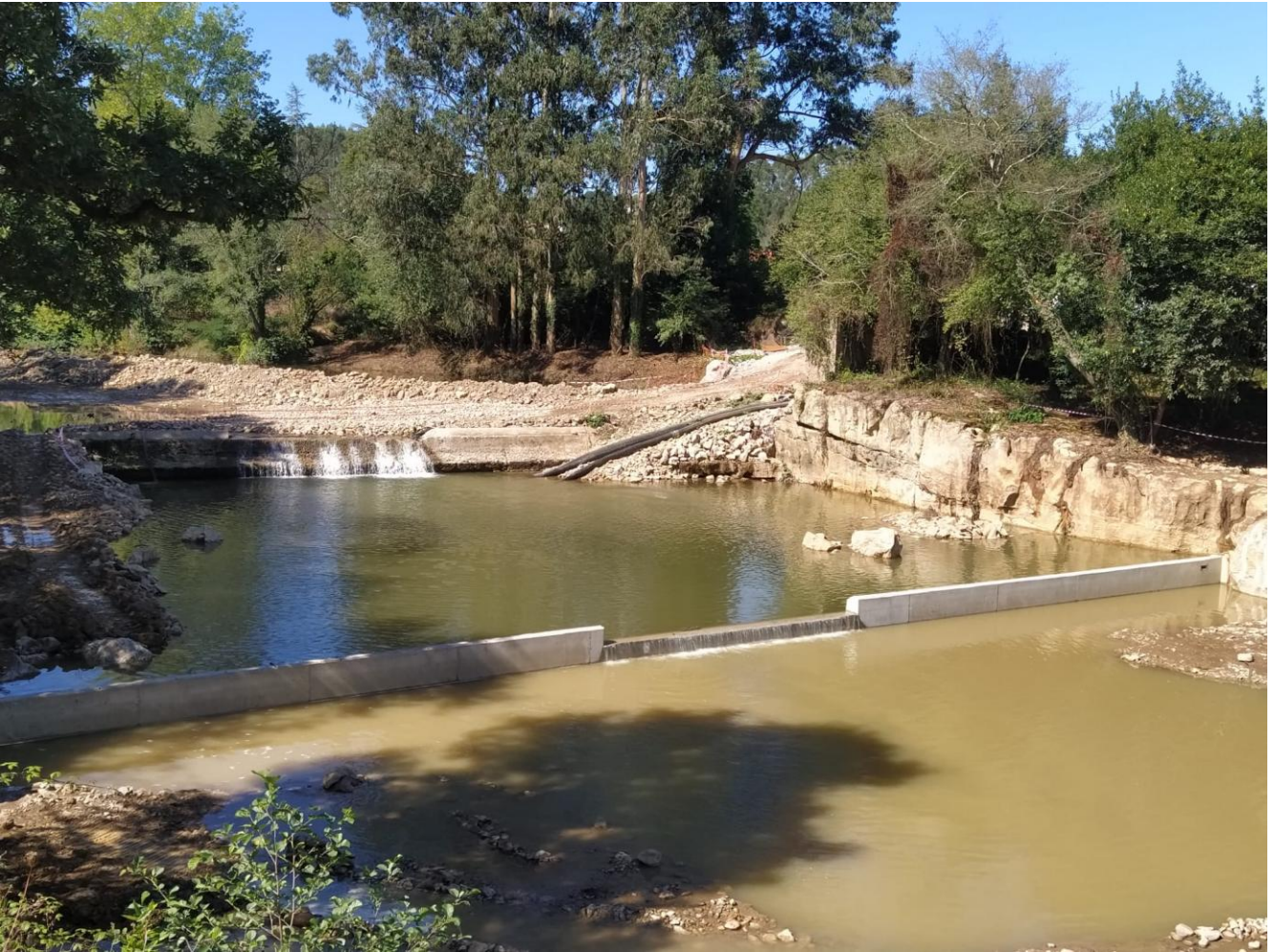
La presa tras quitar el encofrado
