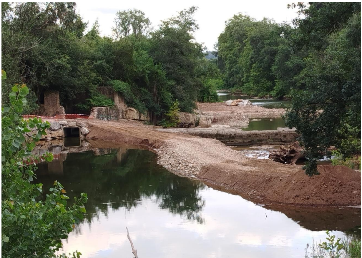
Se inician las obras del nuevo SAIH construyendo un dique que desvíe las aguas hacia el aliviadero abierto en las compuertas del canal de abastecimiento de la central eléctrica Pavón.
