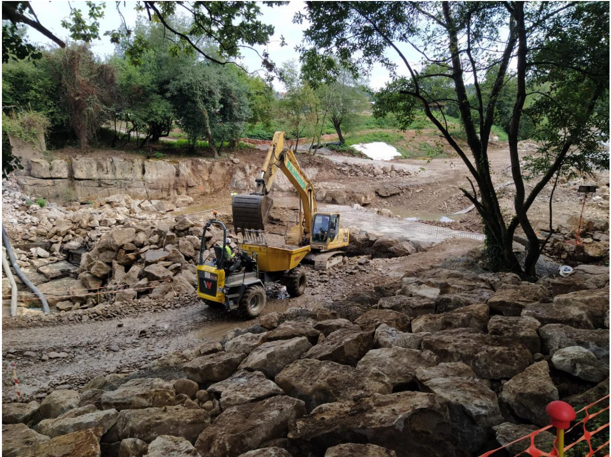
Las máquinas realizan un fortísimo impacto en la zona demoliendo los márgenes, construyendo rocas de protección y trasladando materiales para abrir los cimientos de la nueva presa.
