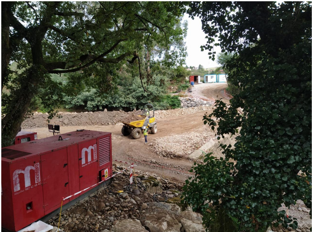
Se refuerza el dique de contención porque una violenta crecida del saja habría sido destructiva para las obras.
