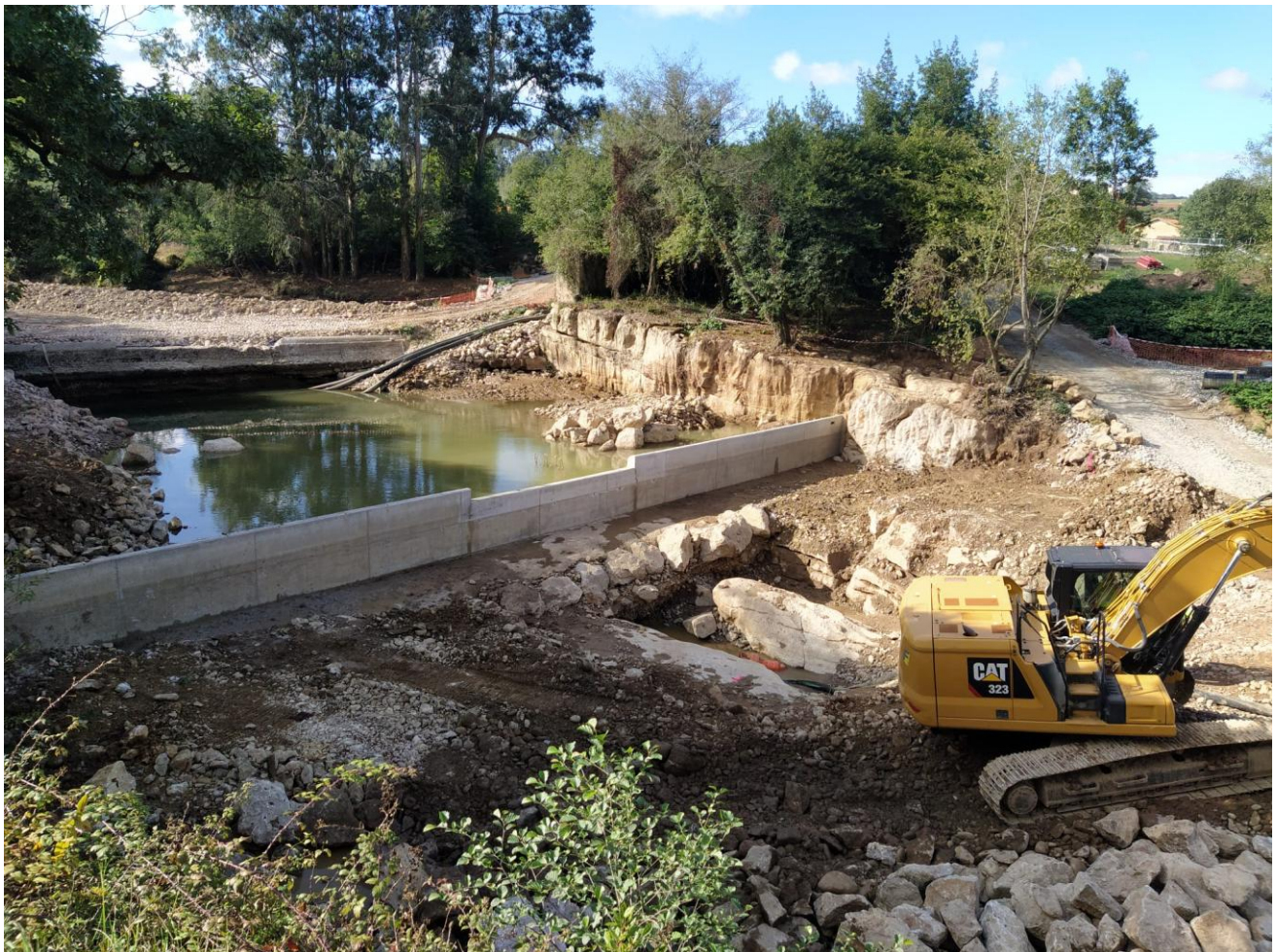
La presa tras quitar el encofrado
