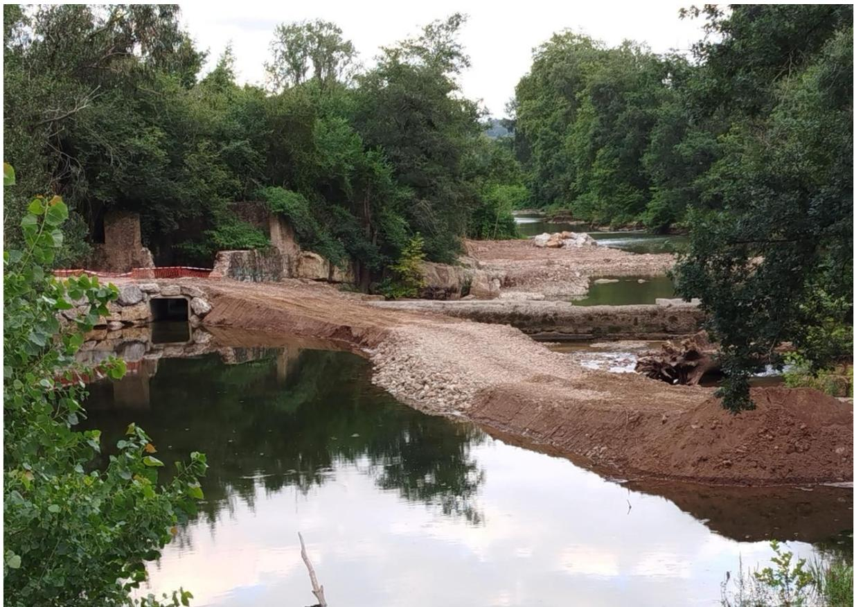
Se inician las obras del nuevo SAIH construyendo un dique que desvie las aguas hacia el aliviadero abierto en las compuertas del canal de abastecimiento de la central eléctrica Pavón.
