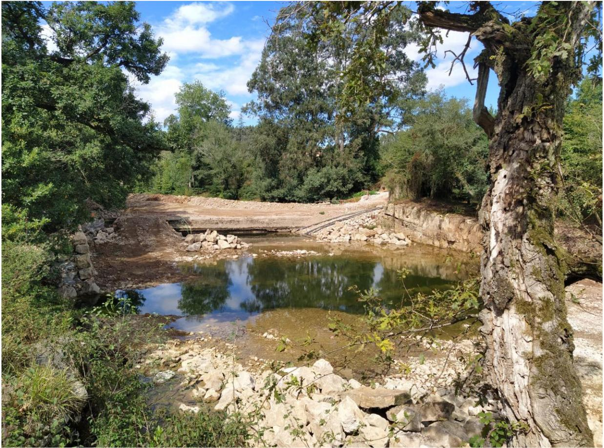
A pesar del dique de contención, las aguas se filtran por debajo inundando la zona de obras.
