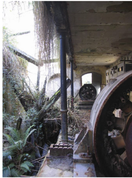
Sala de máquinas.
