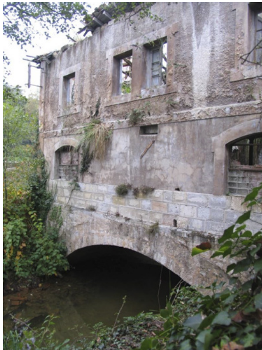
Edificio de turbinas, sala de máquinas y vivienda.
