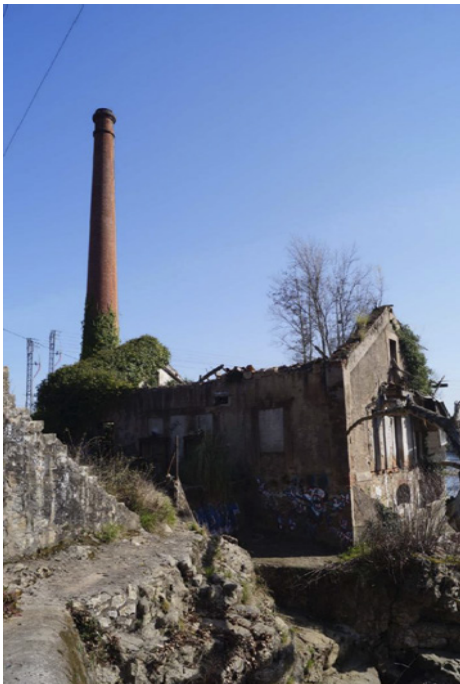
Edificio de turbinas, sala de máquinas y vivienda. Chimenea. (Red de Patrimonio Industrial de Cantabria)
