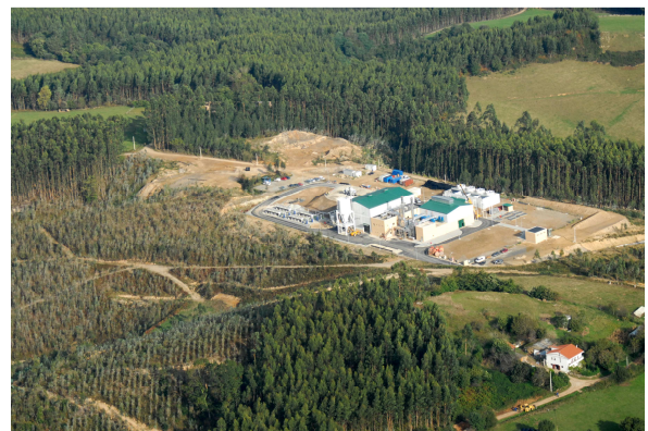
PLANTA DE SECADO TERMICO DE LODOS
