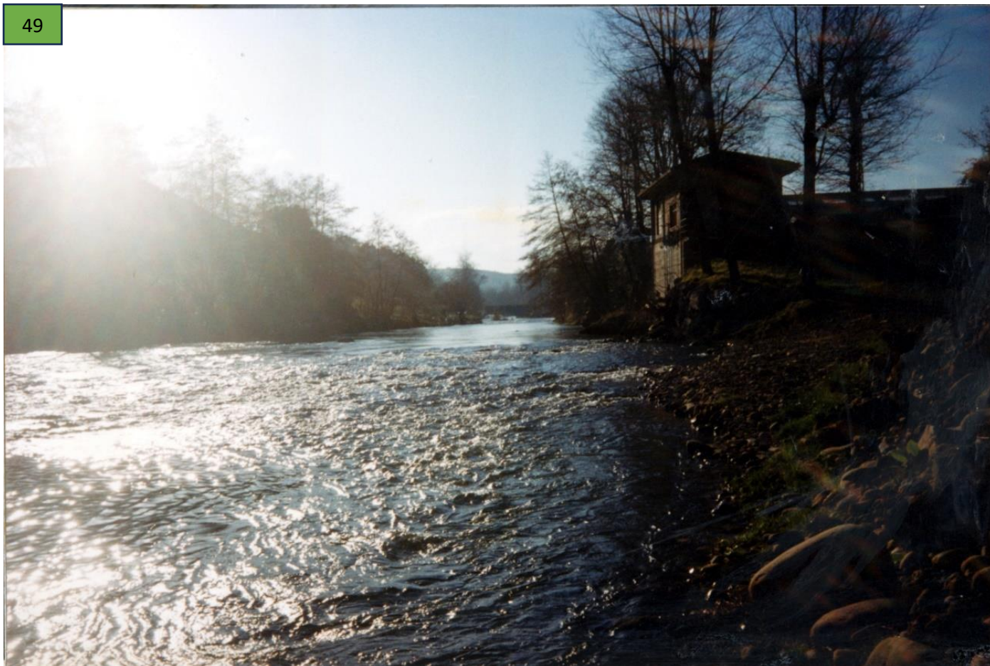
Bombeo de captación de agua en “El barrio de la Agüera”
