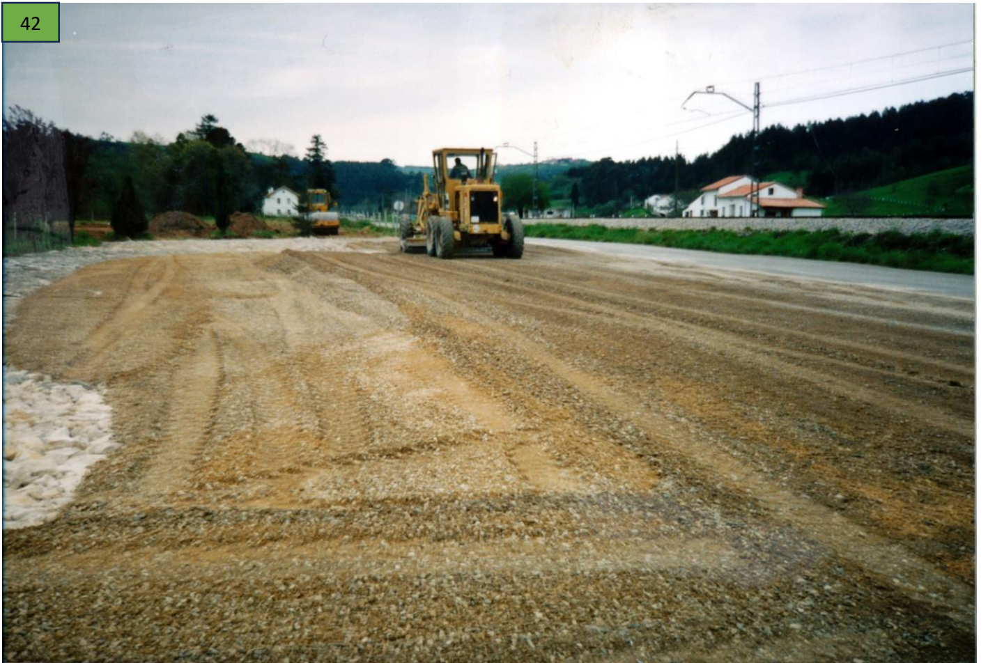
Aparcamiento y pista polideportiva en el Camarao
