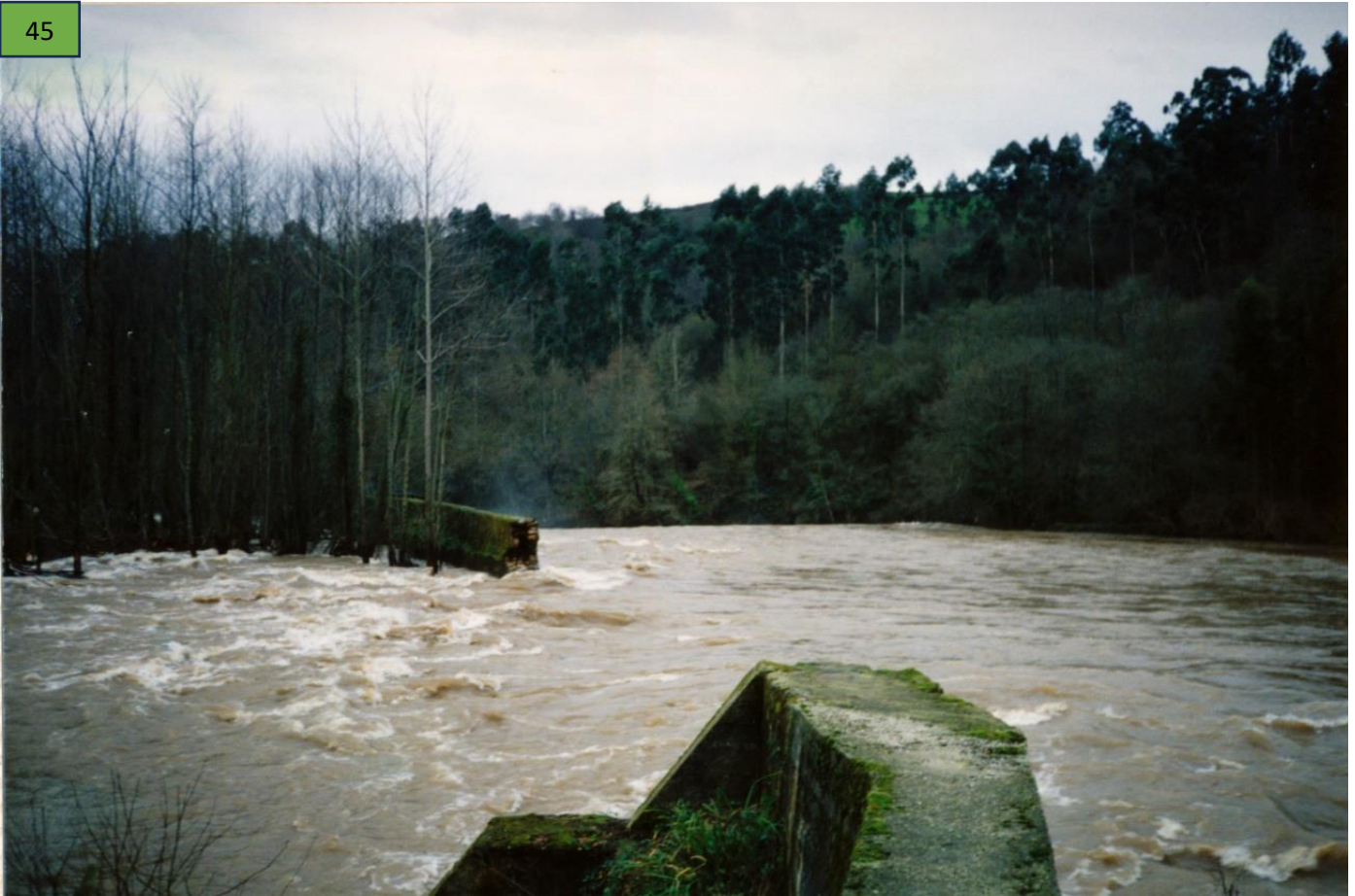
Rotura del muro de contención a las crecidas del río Saja
