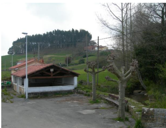
Lavadero y abrevadero de Munío
