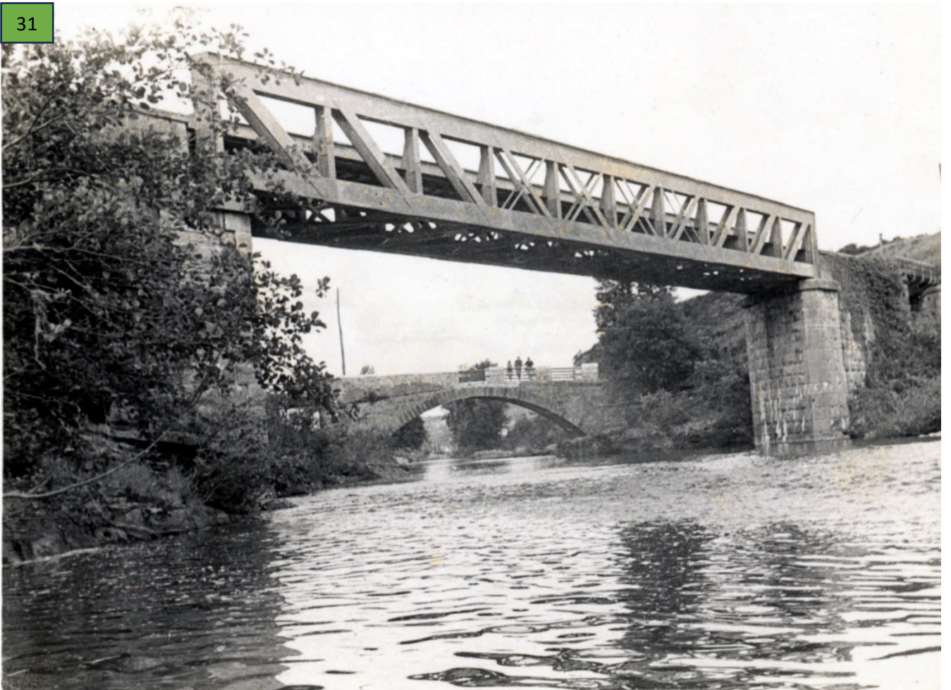
El Pontón y el puente de FEVE
